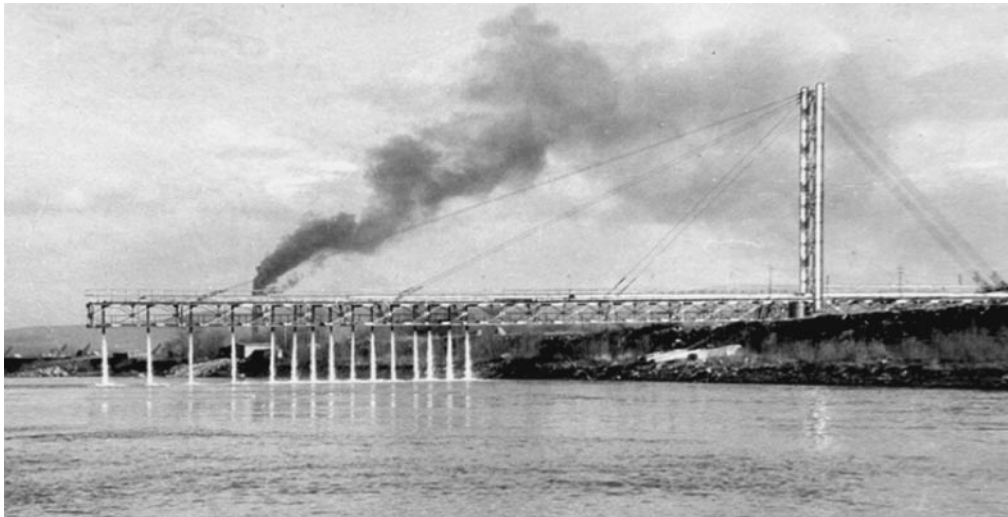
Рис. 8.14. Поверхностный рассеивающий выпуск промстоков Селенгинского ЦКК в левом рукаве Селенги (течение слева направо)
