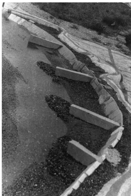
Рис. 10.17. Засыпка крупным камнем контура размыва у оголовков шпор
