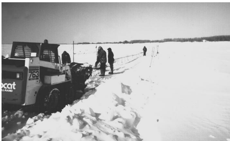
Рис. 12.5. Установка в ледяном покрове нефтенаправляющего экрана на р. Оби у с. Локосово, март 1999 г. (вид против течения)
