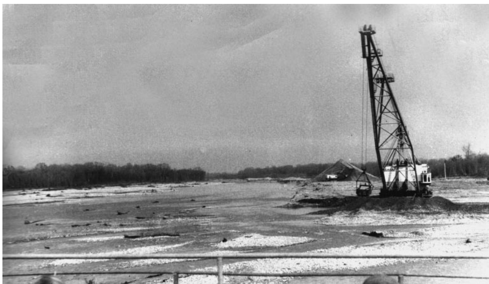
Рис. 10.31. Добыча аллювия из русла р. Лабы в районе п. Мостовской
