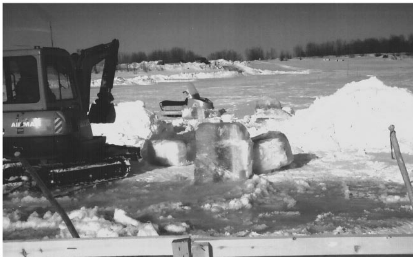
Рис. 12.8. Подготовка участка ледового поля для демонстрации действия нефтенаправляющего экрана: а – расчистка льда от снега и складирование его в гурт; б – извлечение льда из нефтесборной майны и складирование его у снежного гурта
