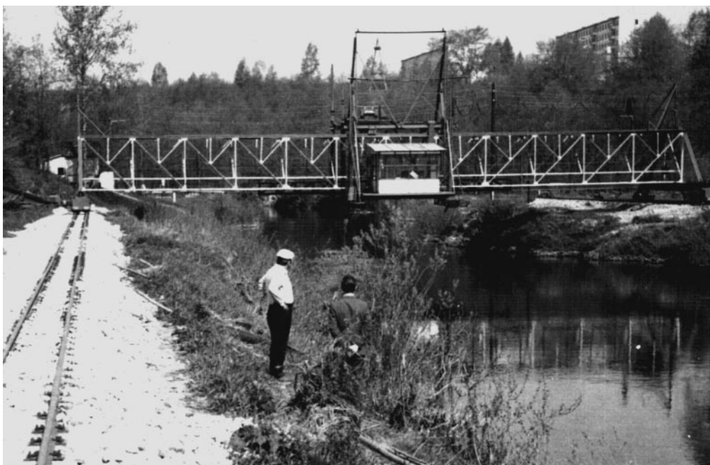
Рис. 2.20. Передвижная эстакада после реконструкции
