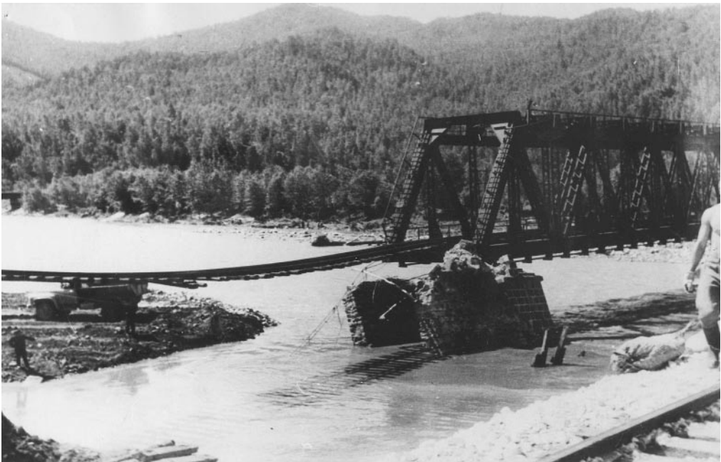
Рис. 10.11. Мостовой переход через р. Утулик после разрушительного паводка 1971 г.
