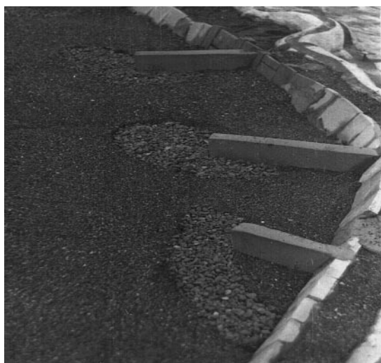
Рис. 10.17. Засыпка крупным камнем контура размыва у оголовков шпор
