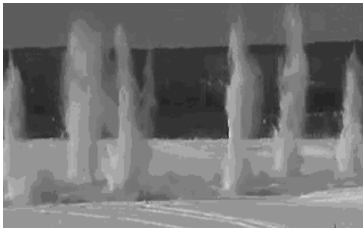
Рис. 10.1. Разрушение ледяного покрова Томи у Томска взрывами.
