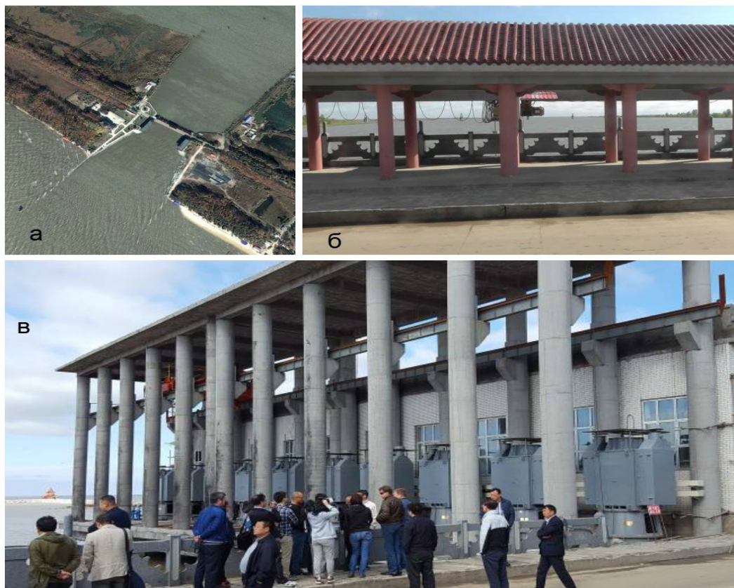
а – вид из космоса, б – павильон затворов, в – насосная станция
