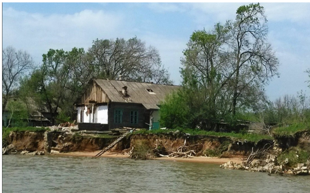
Рисунок 2.4 – Размыв берега у жилых домов по ул. Набережная в с. Новокачалинск
