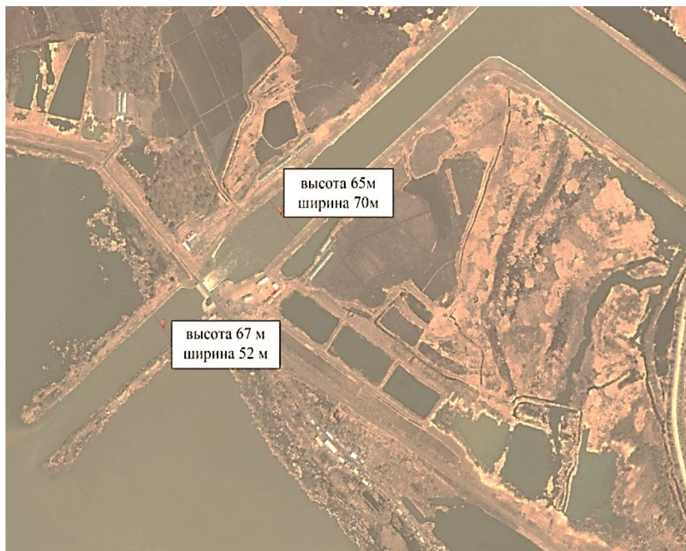
Рисунок 5.18 – Район ГТС, регулирующего сброс воды в канал
