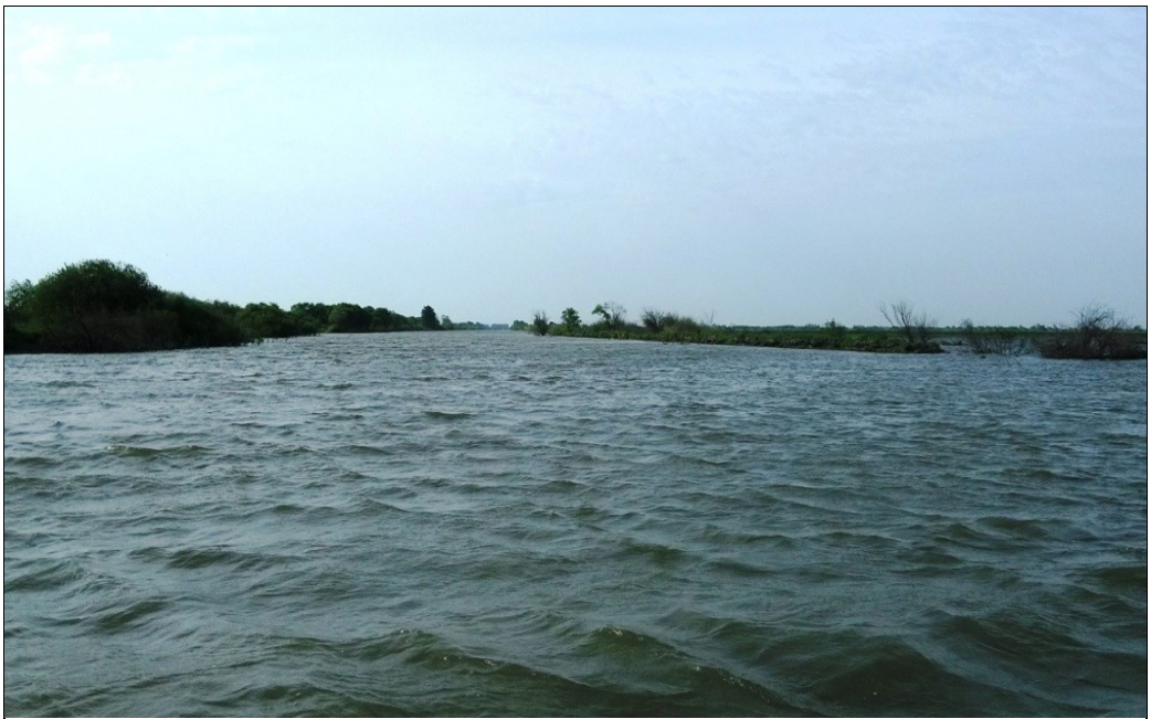
Рисунок 2.6 – Затопленный Сиваковский магистральный канал
