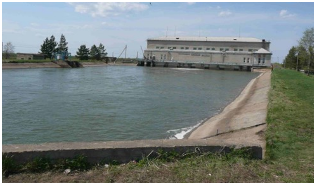
Рисунок 5.31 – Сиваковская насосная станция
