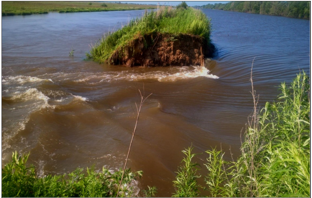
Рисунок 2.7 – Размыв дамбы обвалования в с. Сиваковка
