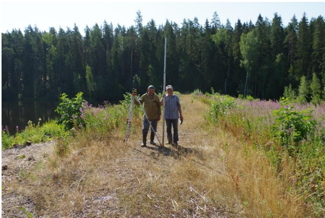
Рисунок 2.111 - Вид земляной плотины на правом берегу выше шлюза Пялли.
