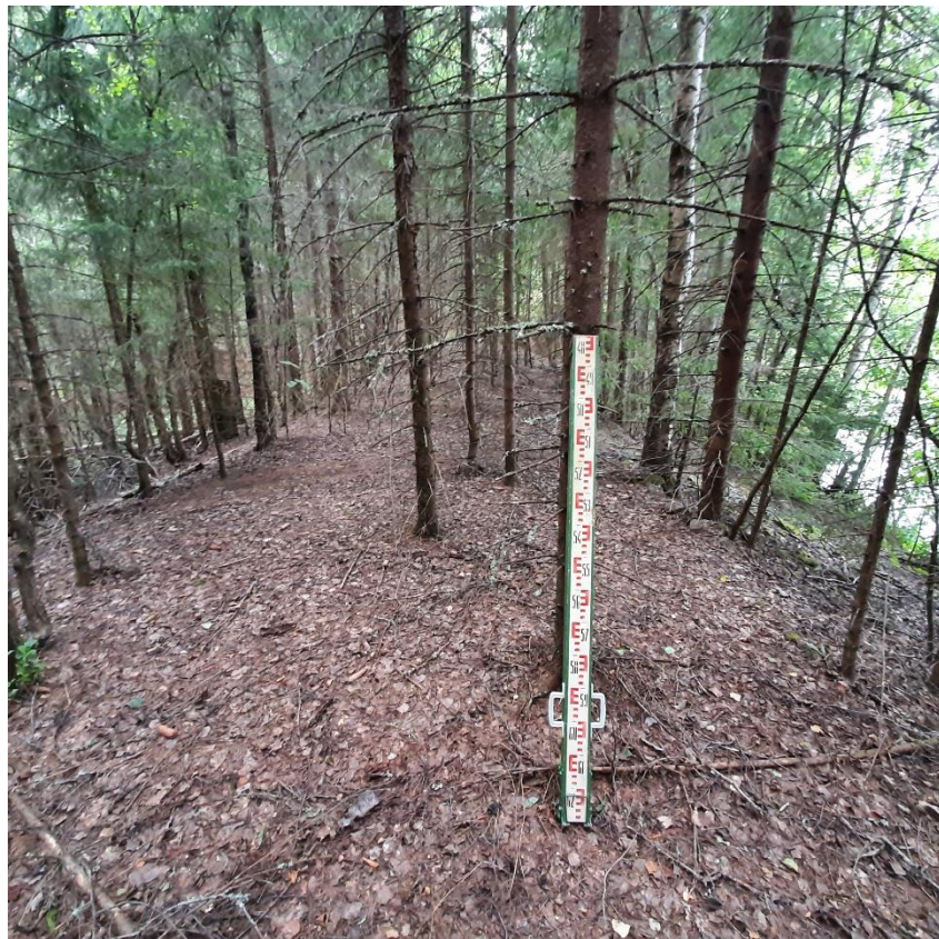
Рисунок 2.110 - Вид земляной плотины на правом берегу ниже шлюза Илистое
