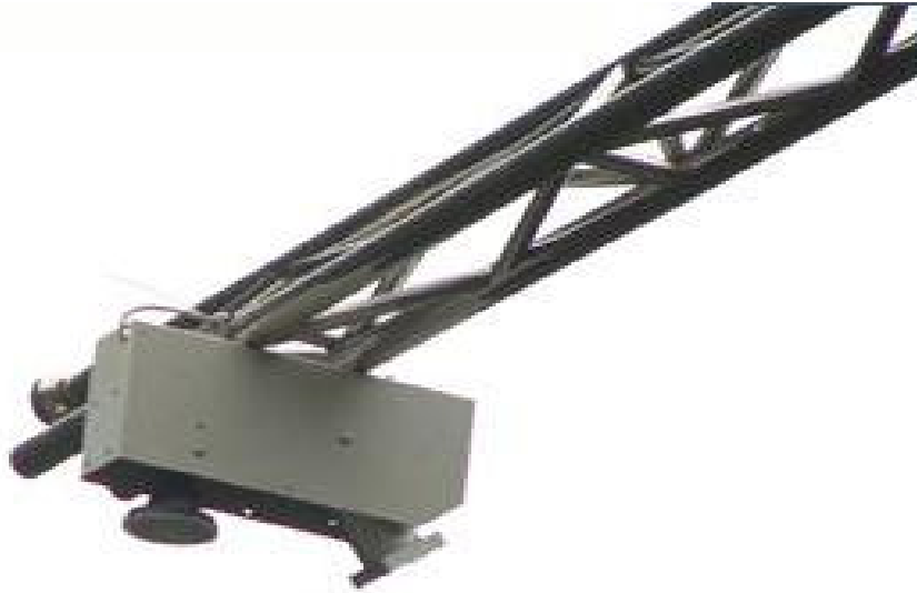
Рисунок 17 – Установка системы измерения на конструкциях моста
