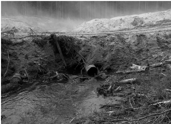
Рисунок Ж.3 — Строительство перехода временной технологической дороги с использованием обрезков труб
