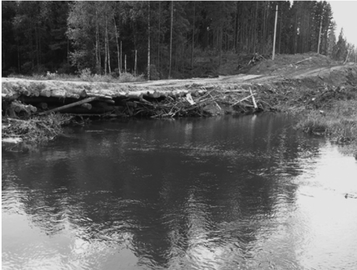
Рисунок Ж.2 — Строительство бревенчатого перехода временной технологической дороги через малую реку
