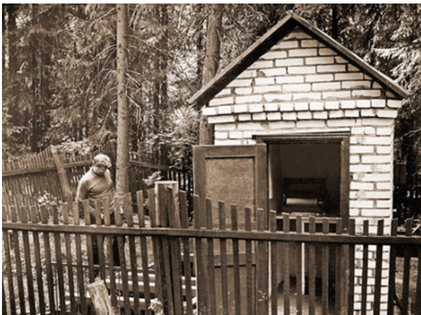
Рисунок 3.13. Гидрометрическое сооружение на ручье Западный-1
