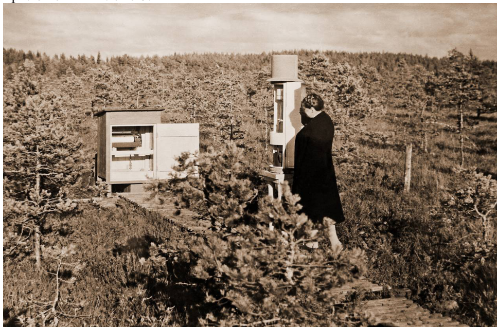
Рисунок 6.7. Установка для определения коэффициента подъема уровня болотных вод
