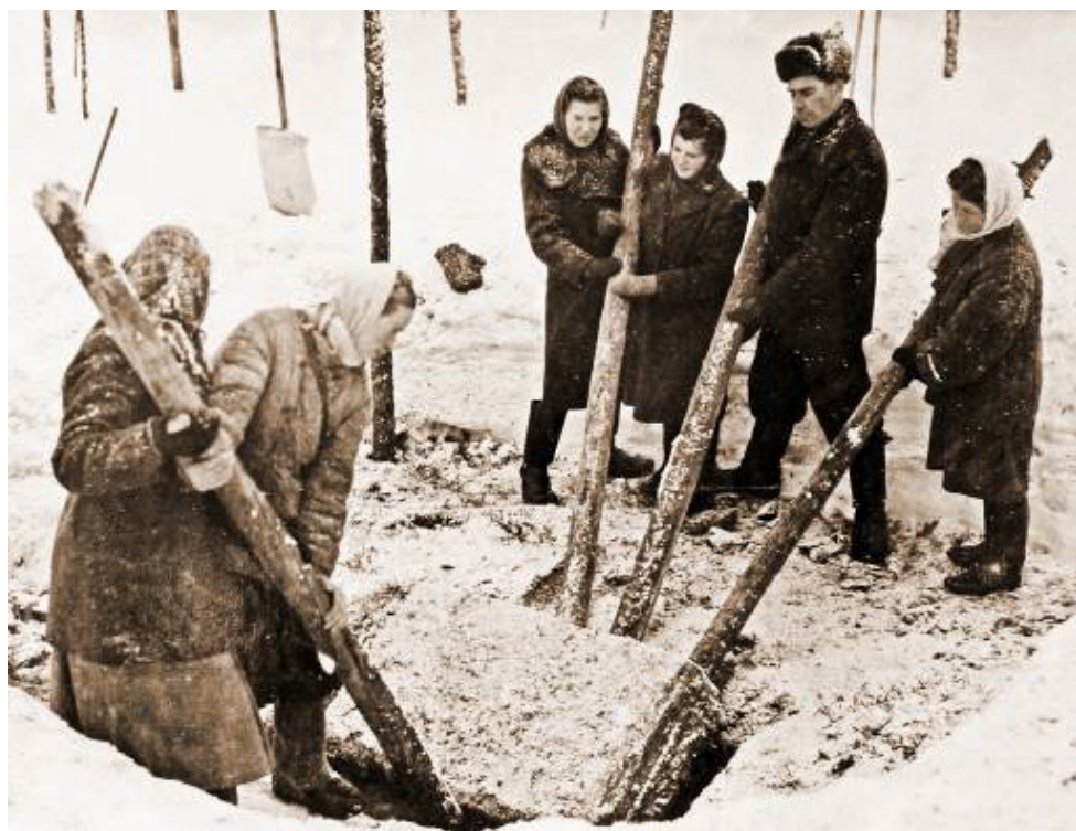
Рисунок 6.3. Отбор монолита для изучения фильтрационных свойств
