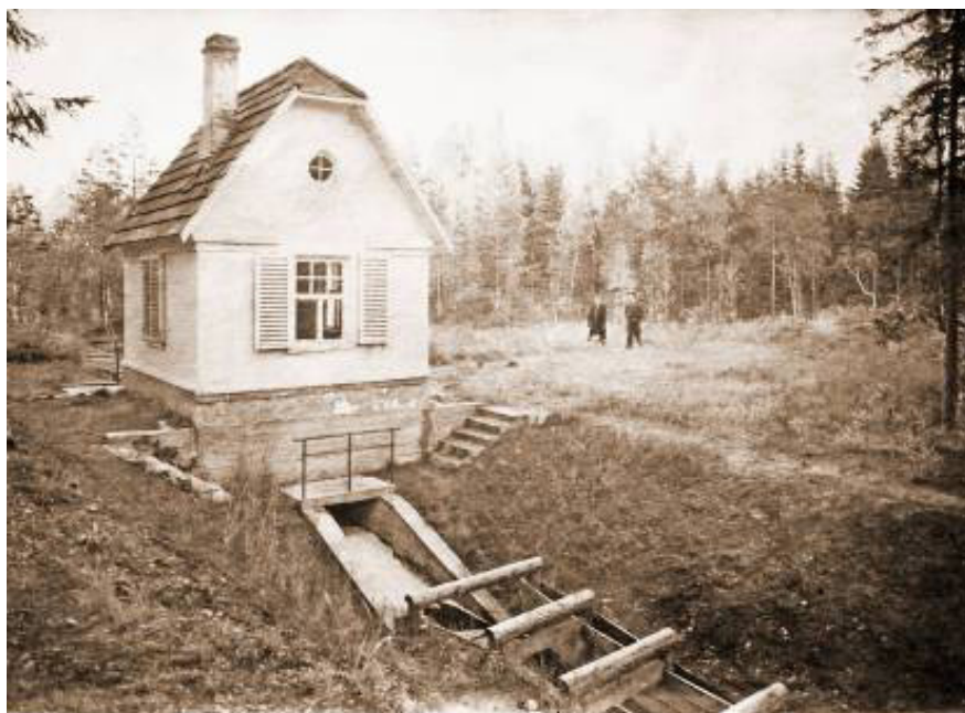
Рисунок 3.11. Гидрометрическое сооружение на ручье Южный
